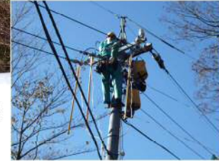
菅沼ダム線の作業現場です。とても広い範囲で装柱部取替作業を行っています。
